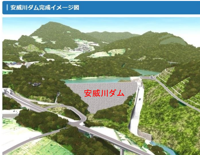
①安威川ダム(大阪府/大阪府茨木市) 〈中央コア型ロックフィルダム〉
