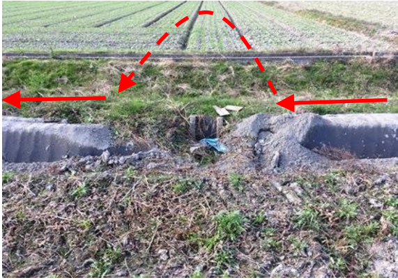
水口・尻溝は施工しない
