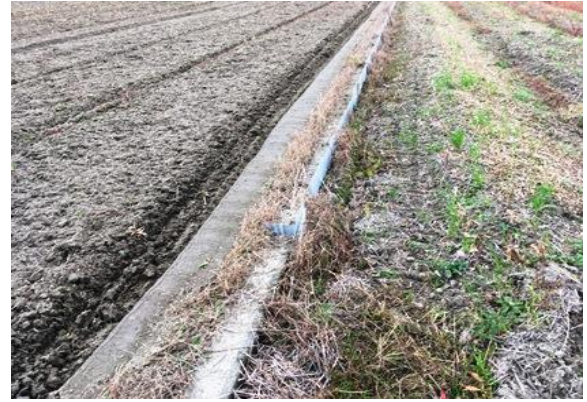
畔シートがあるところも施工しない
