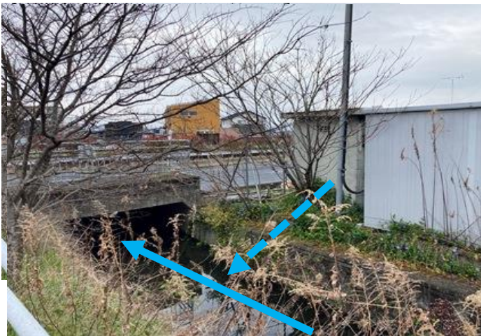
(第一ポンプ場…地下水くみ上げ)
