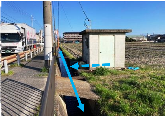
(第二ポンプ場…地下水くみ上げ)
