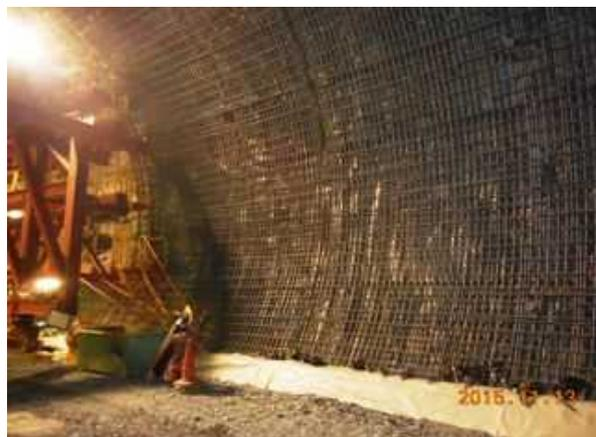
一般的な道路トンネルと異なり水圧に耐えるよう鉄筋コンクリート
