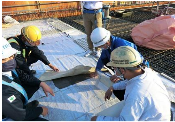
右側は鉄筋組立中
