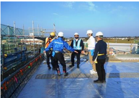
完成した床版上で
