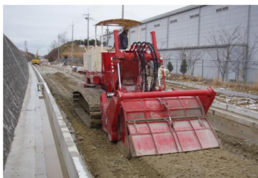
というわけで右の写真は、先日あった名神集中工事に参加する前に現場代理人として担当していた栗東水口道路小野西改良工事のものです。平成24年6月～平成25年3月末までを工期とした国土交通省さんの発注工事でした。てんこ盛り協議書類を作ったのですが、結局協議した本体工事は訳あって全中止となり、最後の年度末に超突貫舗装工事をする事になったという伝説？の工事です。橋面及び土工部あわせて約2.2万㎡を超える排水性舗装工事の一部に約2kmの路床安定処理工（スチライザー）があり、右はその写真となります。数量的には上記にくわえて排水構造物が720m、橋梁防護柵が約1.5km、橋面防水が約5kmといった具合でした。私自身は変更工事の協議書類や数量計算書及び図面の作成などで精一杯な状態で、恥ずかしながら現場はお任せ状態でした。しかしながらそこは昭建スタッフ、監理技術者を筆頭に各自がやるべきことをきっちり把握していたことで、私の出る幕などほとんどなくて、感覚としては自動的に仕上がっていったという感じでした。評
