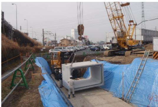
1個当たり約10tのボックスカルバート(B200 x H200)を195個、約370m設置するというものでした。工区も上流側で単工種とあってかなり楽観していたのですが、そうそう旨い話はなく例のごとく問題だらけでした。列挙すると、当工区の下を通行止めなしで横断する必要があり、しかも入口がその1箇所だけしかない。地盤が悪く製品搬入のためには施工延長分の通路養生が必要。隣接して既設構造物があるなど利用可能幅が狭く施工に必要な50t級クレーンを据付けするスペースがない。地域一帯の水が当工区に集積してくる上、水替にしくじれば下流工区にも影響する。当工区内に別工事の作業通路があるなど、隣接工事が多数あり相互にリンクしているため調整が必要。追加工事として、最上流部迂回水路の取壊しとU型水路(U-2700 x 200)による既設水路への接続を指示された。などなどです。主体となる施工方法については即決で、全施工延長について敷鉄板に
